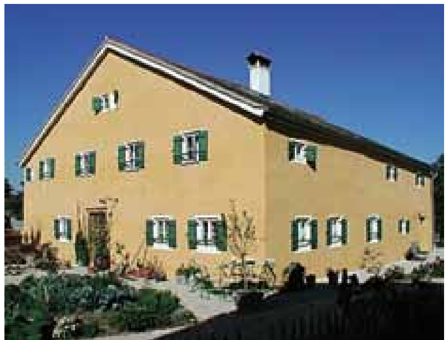
Der Stoffelbauernhof der Familie Klötzel in Grampersdorf, Bauzeit 1719
