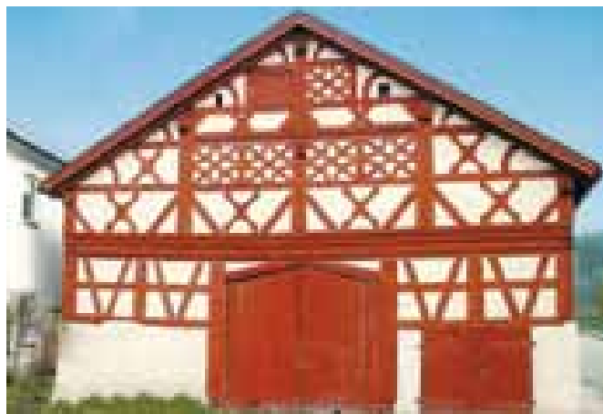
Jurascheune, Bauzeit 1709, mit Schmuckfachwerk in Inching
